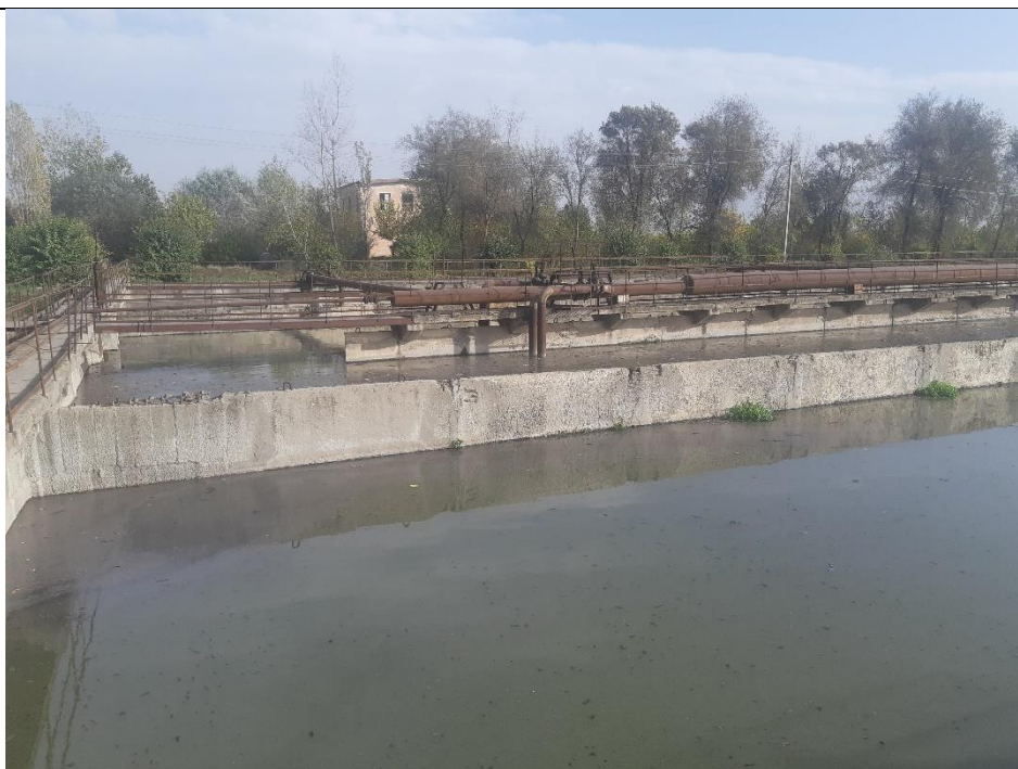
Аэротенки/Airtanks non functional
