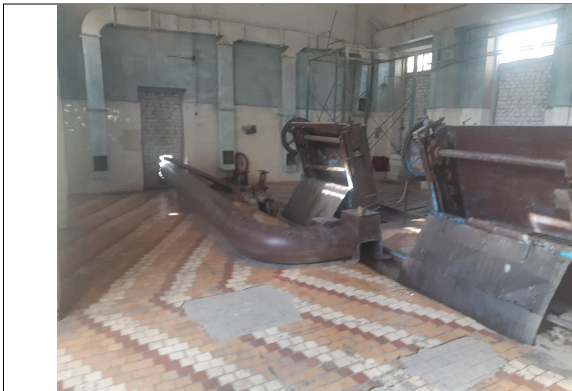
Механические решетки/mechanical grids %60 functional
