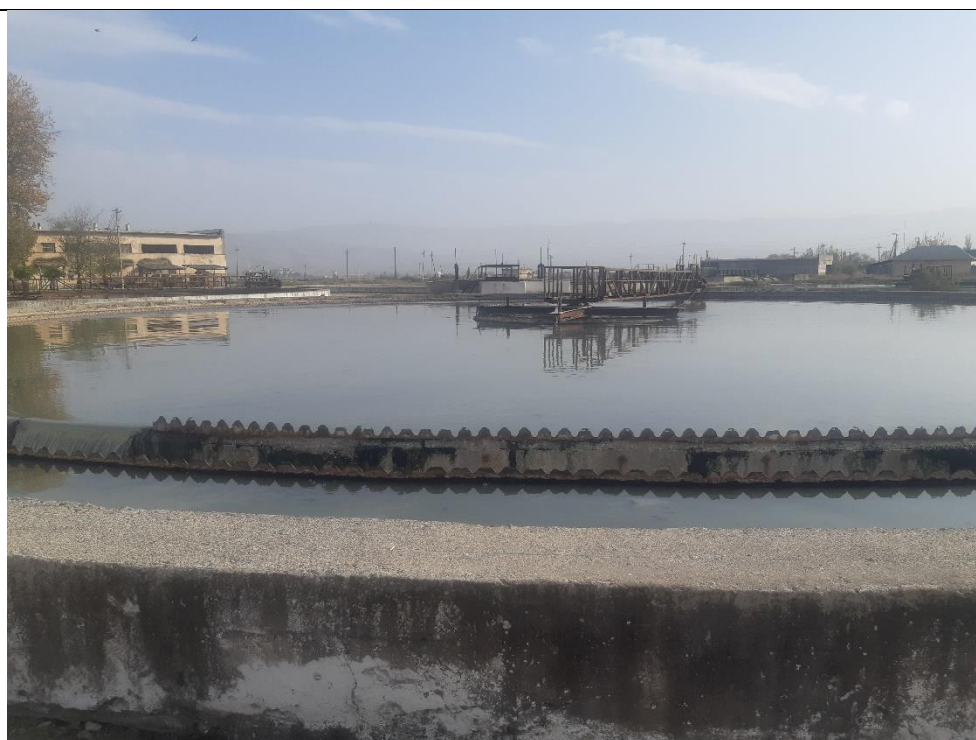
Вторичные радиальные отстойники/secondary settlement ponds
