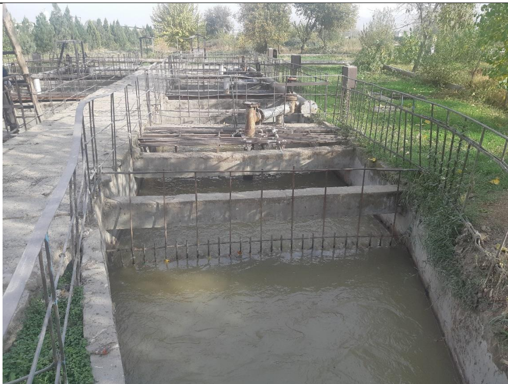
Горизонтальные песколовки/ Horizontal sand traps %40
