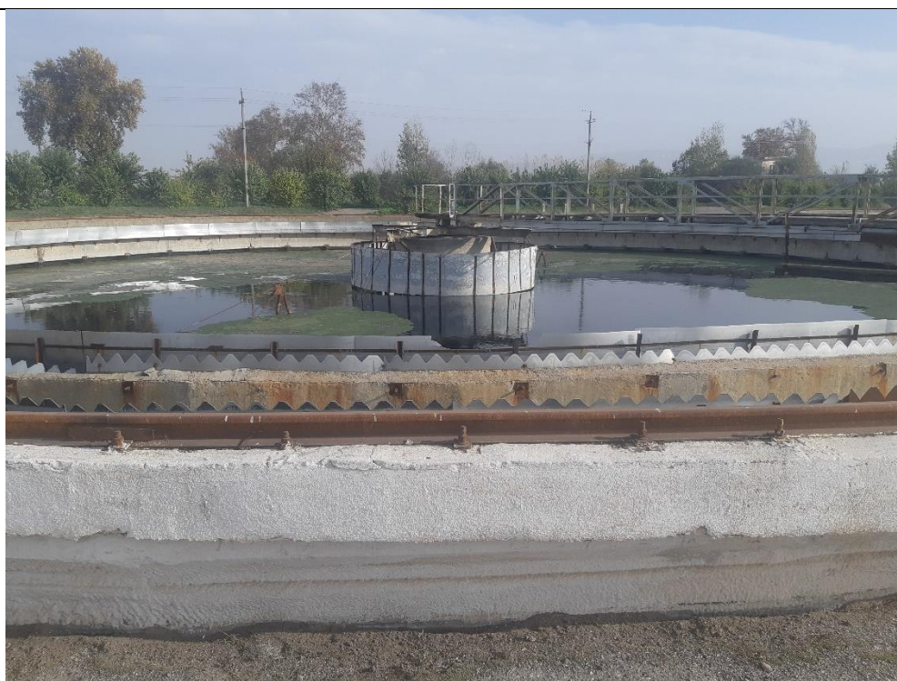
Первичные горизонтальные отстойники/Primary settlement ponds
